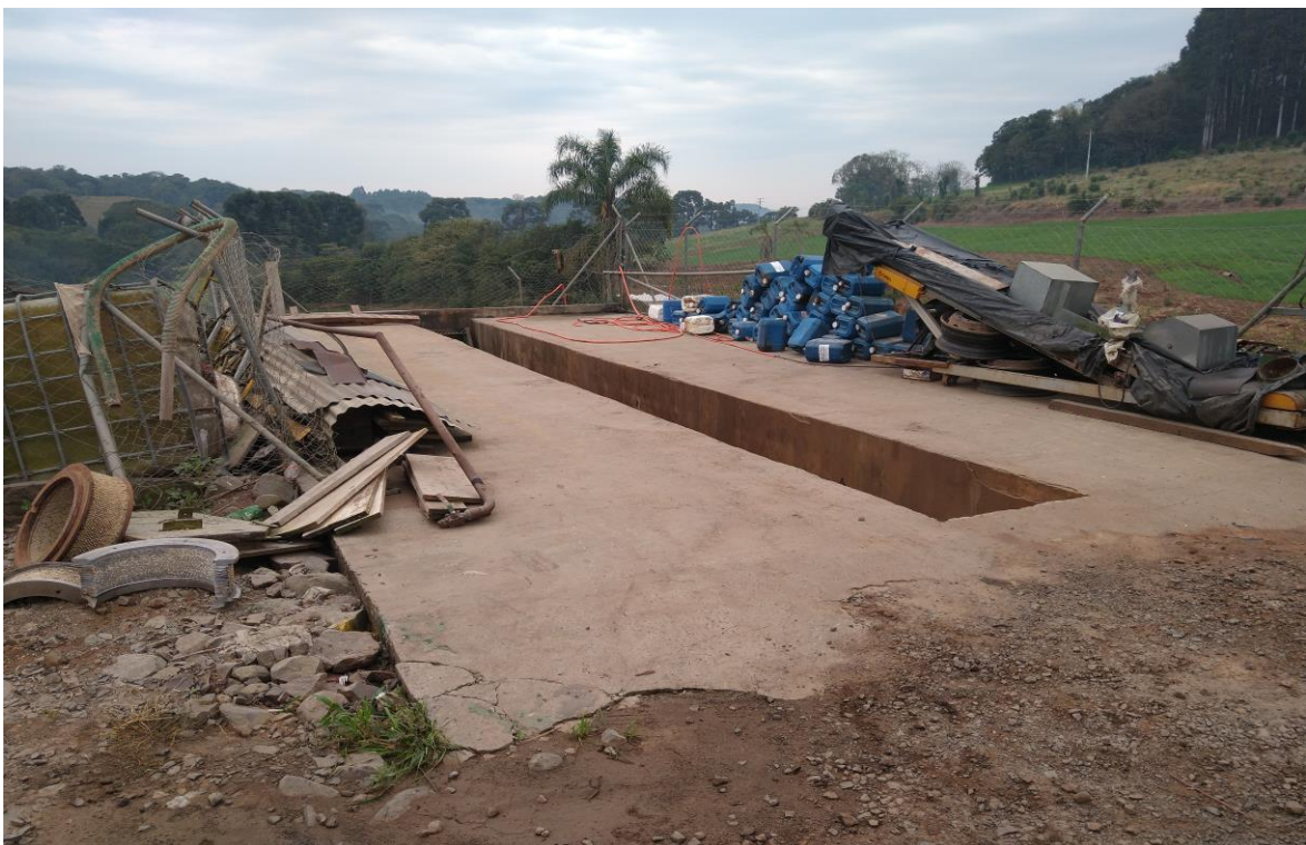
Vista da rampa de lavagem de veículos.
