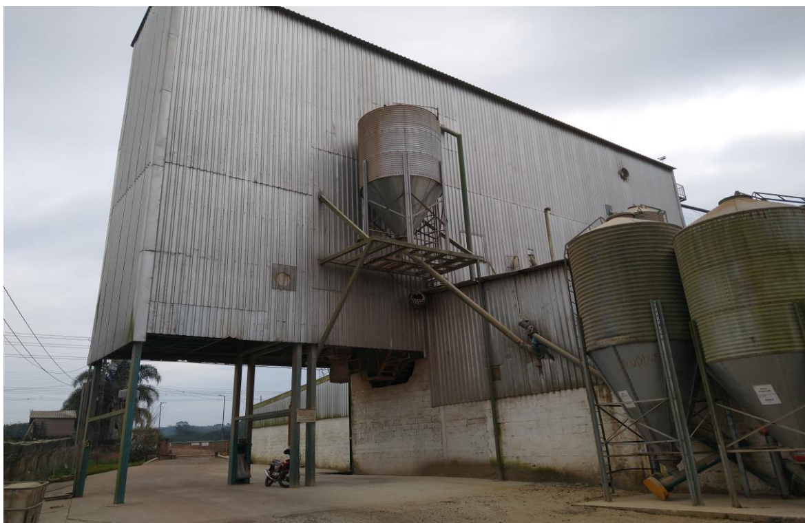
Vista da área de expedição a granel.
