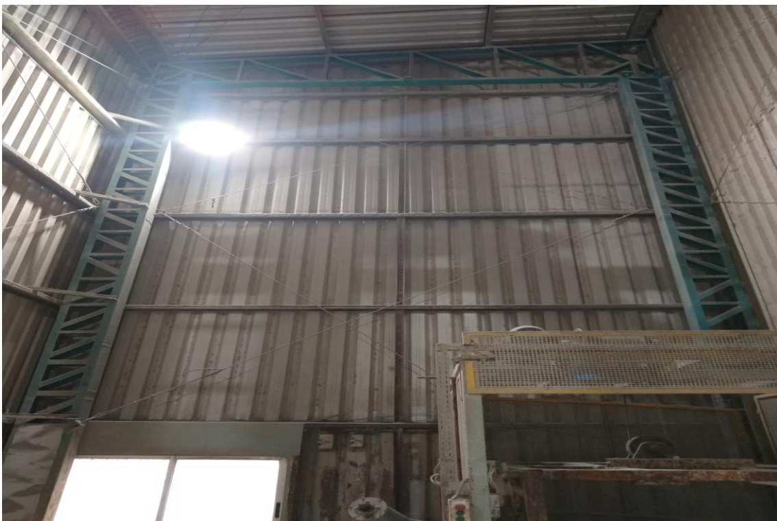
Vista da estrutura metálica do pavilhão e do fechamento lateral. Do lado direito abaixo, vemos o elevador de insumos.
